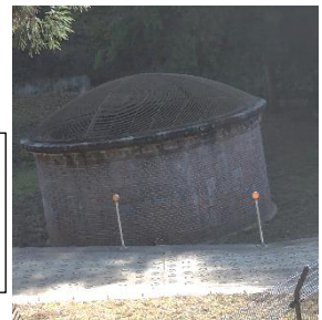
④峠付近の豎坑(たてこう) 疎水のトンネルを掘る時に、縦に掘り進んだ跡だそうです。
